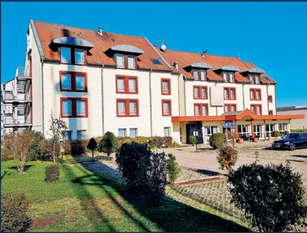
Hotelanlage in Schkeuditz, Pos. 11
