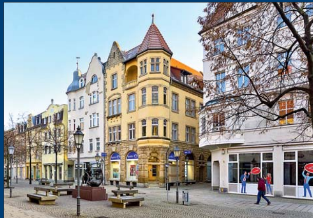
Denkmalgeschütztes Wohn-/Geschäftshaus in Zeitz, Pos. 43
